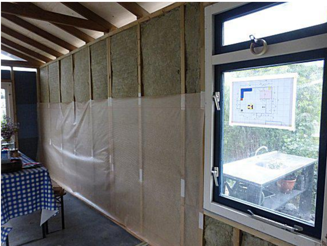
Buitenwanden geïsoleerd met steenwol Rockwool 45mm.
