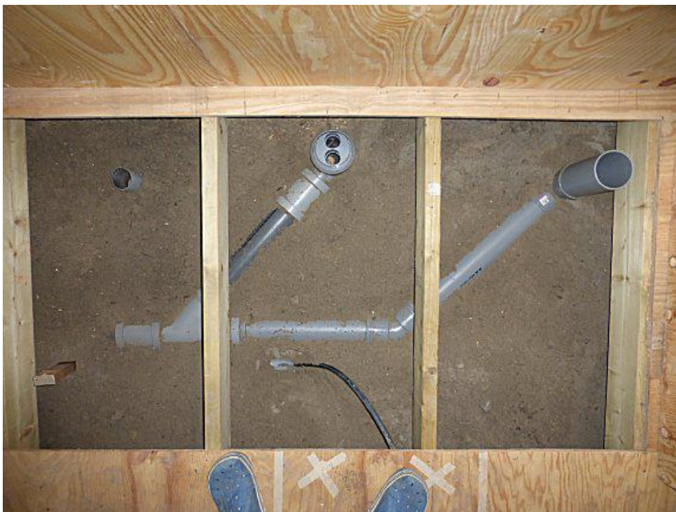
Vloer in de badkamer is open te maken en geeft toegang tot de hoofleidingen van riool en aanvoer water. Water aanvoer is tyeen slang 16mm die ter bescherming in een PVC pijp zit. Waterleidingen zijn van QuickFit systeem, 12mm.
