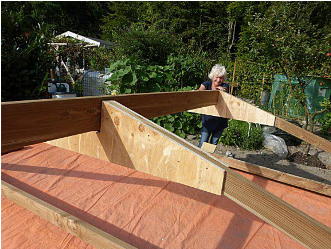
Detail A-frames en nokbalk (45x160x400).
