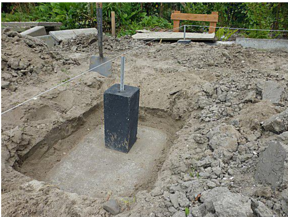
Poeren staan op een grindtegel 40x60x5cm ingegraven in het zandbed op een diepte van circa 30 cm.
