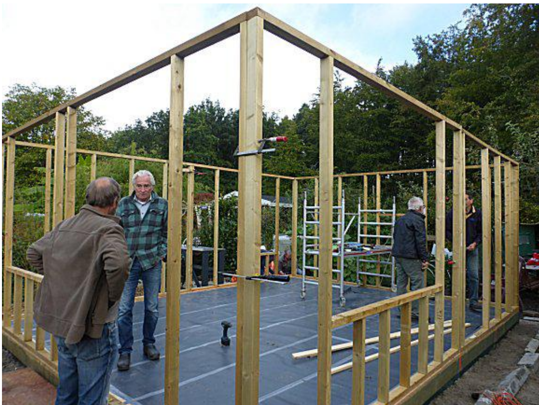
Alle frames (wanden en dak zijn in een dag regendicht geplaatst). De wanden zitten geschroefd op de vloer en onderling.
