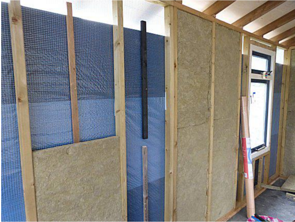
Buitenwanden geïsoleerd met steenwol Rockwool 45mm.
